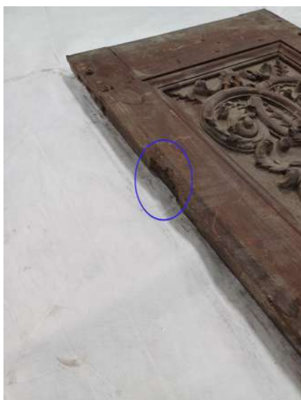
Différentes entailles ont été réalisées sur le chant du montant en forme de queue d'aronde.
