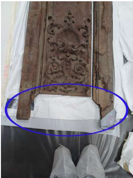
Il manque une traverse au châssis
