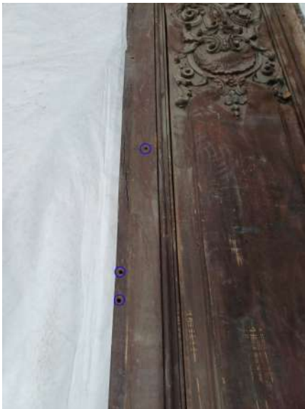
Présence de plusieurs trous dans les montants
