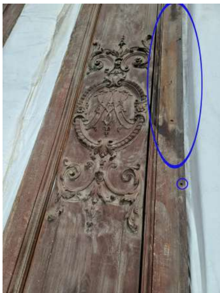
Présence de plusieurs trous dans les montants.
