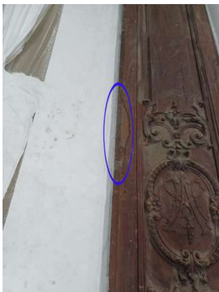
De grosses traces d'anciennes coulures d'eau ont altérées la finition de la Stalle et changées la pigmentation du bois
