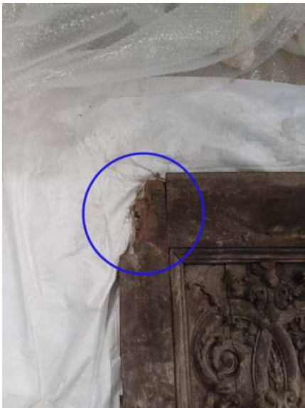
Une partie du montant gauche est manquant en partie haute.
