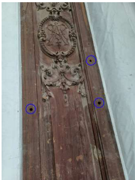
Présence de plusieurs trous dans les montants.
